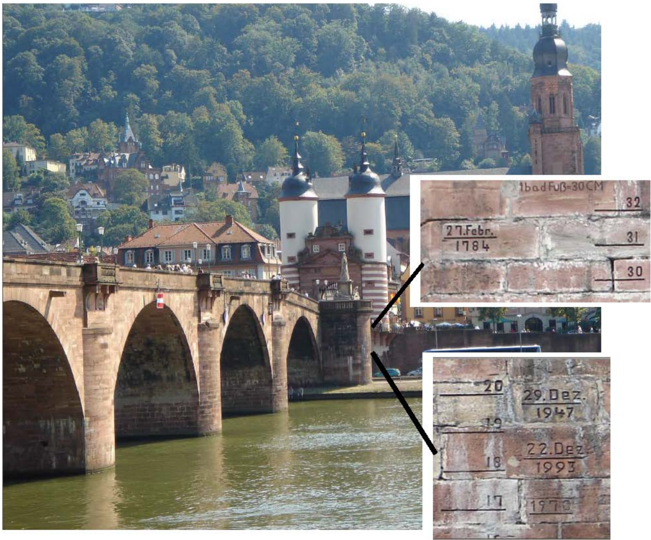
Bild 1: Alte Brücke in Heidelberg mit Hochwassermarken am ersten südwestlichen Brückenpfeiler. Die Pegelwerte sind in der Maßeinheit „badischer Fuß“ eingraviert (aus dem Buch des Autors „Energie und Klima, expert Verlag, 2020).
