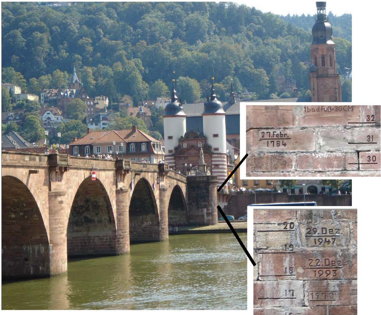
Bild 1: Alte Brücke in Heidelberg mit Hochwassermarken am ersten südwestlichen Brückenpfeiler. Die Pegelwerte sind in der Maßeinheit „badischer Fuß“ eingraviert (aus dem Buch des Autors „Energie und Klima, expert Verlag, 2020).
