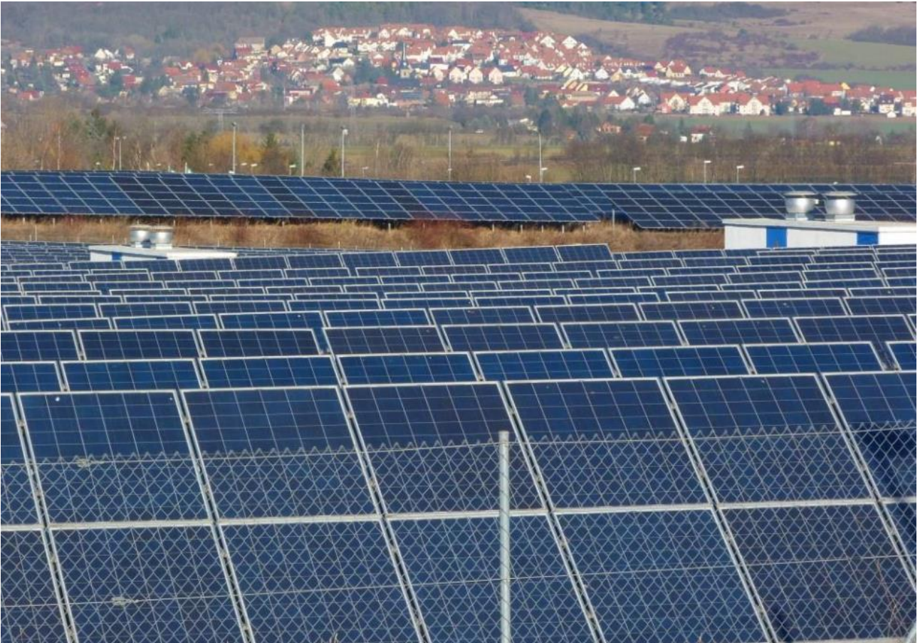
Abbildung 4: Ein riesiger Solarpark, südwestlich der Stadt bei Nohra gelegen, heizt Weimar nun kräftig ein. Im Hintergrund eine wärmende Bausünde der 1990er Jahre, das große Neubaugebiet in Gaberndorf am Ettersberg. Foto: Stefan Kämpfe
