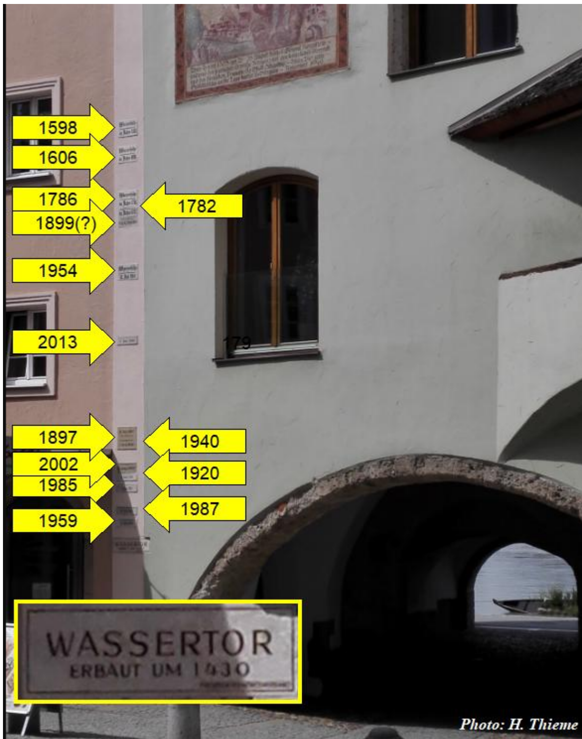
Bild 10 Inn bei Schärding. Hochwassermarken am Wassertor Quelle
