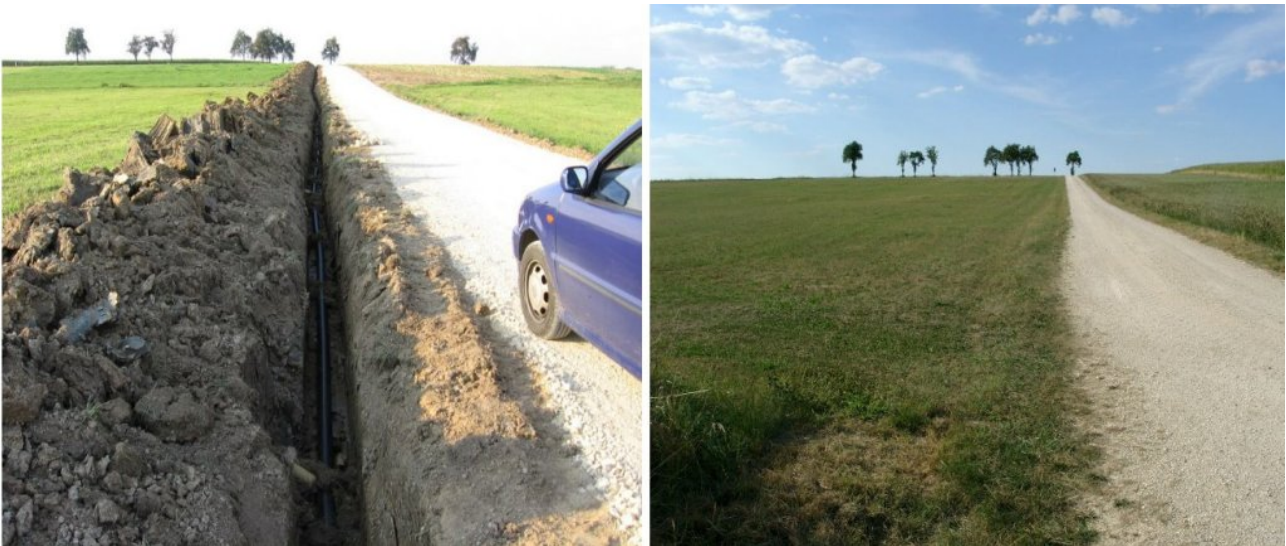
Bild 2: Zur schwarzen Drainleitung entlang des Feldweges münden von links alle 15 Meter gelbe Saugleitungen, welche die Wiese trockenlegen, Die erste ist erkennbar. Im Sommer sieht die Wiese dann braungrüngelb aus mit spärlichem Grasbewuchs im August. (rechtes Bild). So erzeugt man Steppen in Deutschland. Fotos Worm/Kowatsch.
