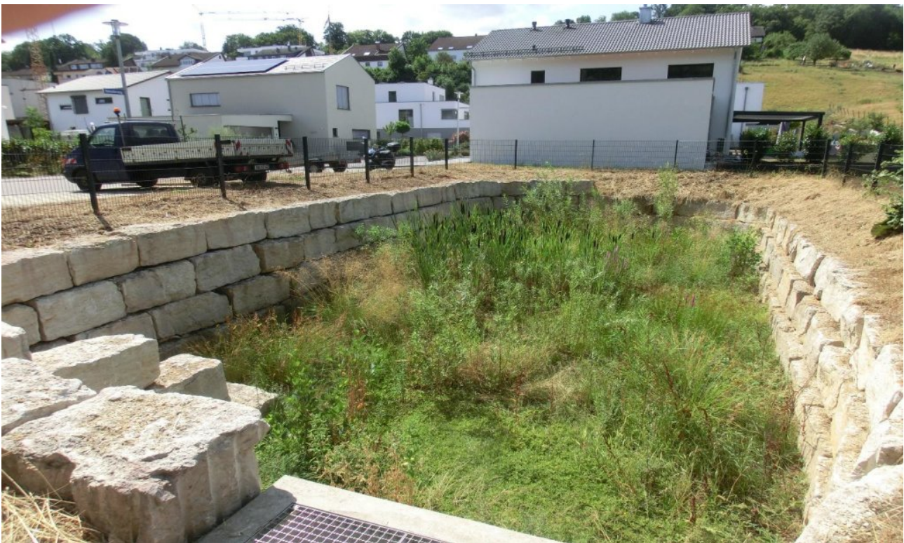
Abb.9a: Offenes Regenrückhaltebecken bei einem Neubaugebiet, Fassungsvermögen etwa 500 Kubikmeter. Das Regenwasser aus den versiegelten Flächen der Siedlung wird hier zwischengespeichert und kann versickern, im Sommer auch verdunsten. In 10 Jahren wird das Becken nicht mehr sichtbar sein, da es automatisch mit Nässe liebenden Pflanzen einwächst, die Verdunstung und die Kühlung nimmt dadurch zu. Foto Kowatsch.
