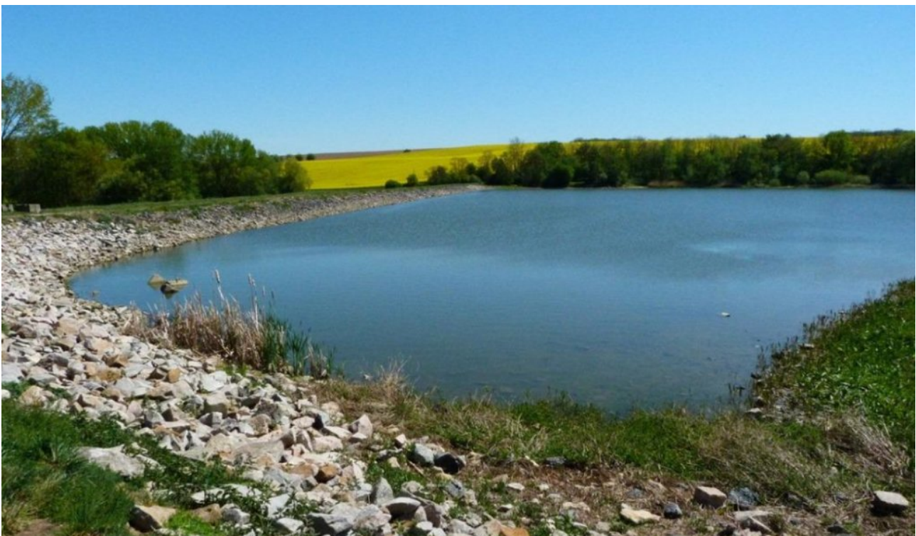
Abbildung 1a: Noch aus DDR-Zeiten stammender Kleinspeicher an einem Bach
