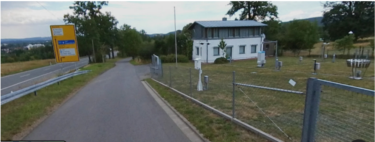
Abb. 2b: Zwei Spuren Bundesstraße Richtung Norden und zusätzlich die Abbiegespur nach Weiden. Direkt vor der Station der breite grüne Planweg. Der Hang ist leicht geneigt und entwässert nach links ins Tal. Man beobachte auch das schützende Gebäude direkt bei den Wetterstations-Elementen.
