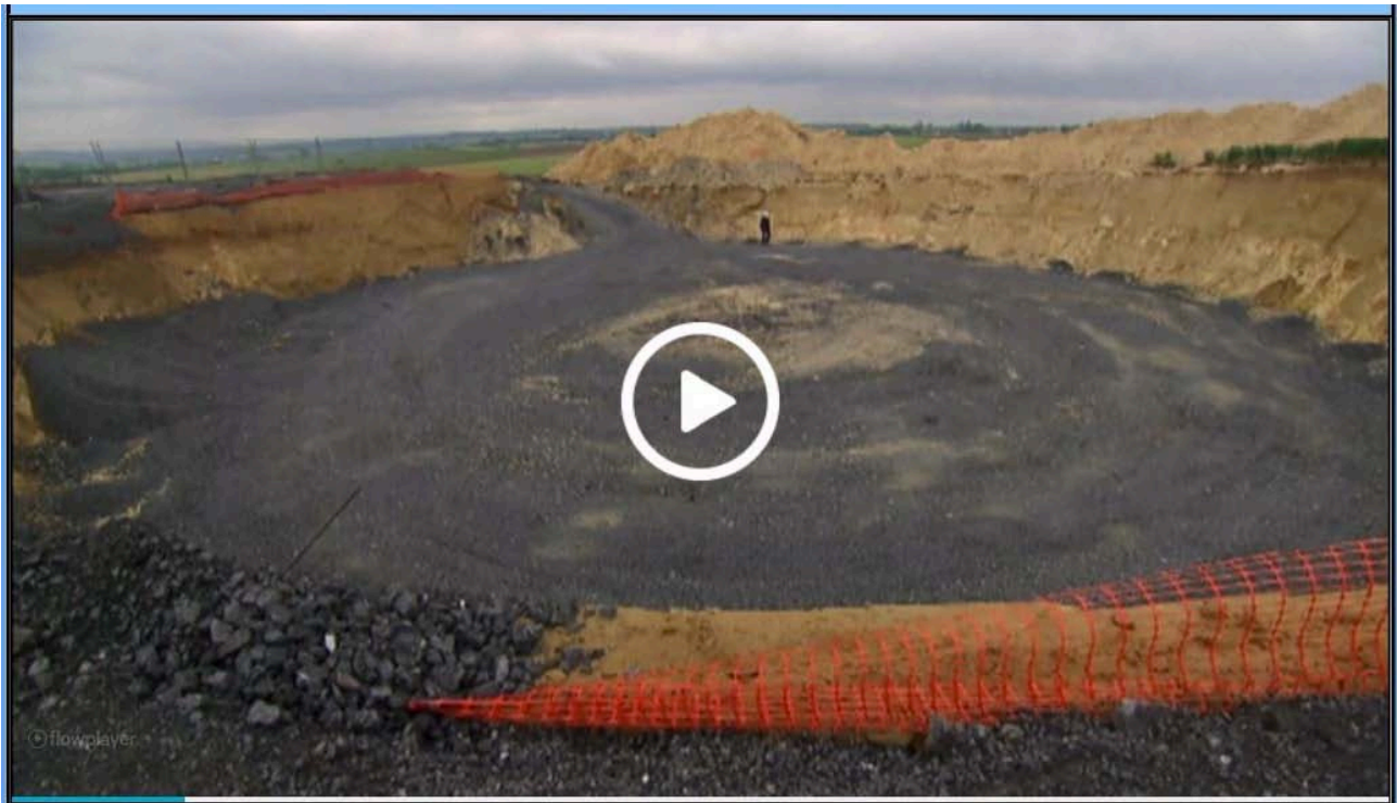
Fundamentarbeiten für Riesen-WEA im Sauerland
