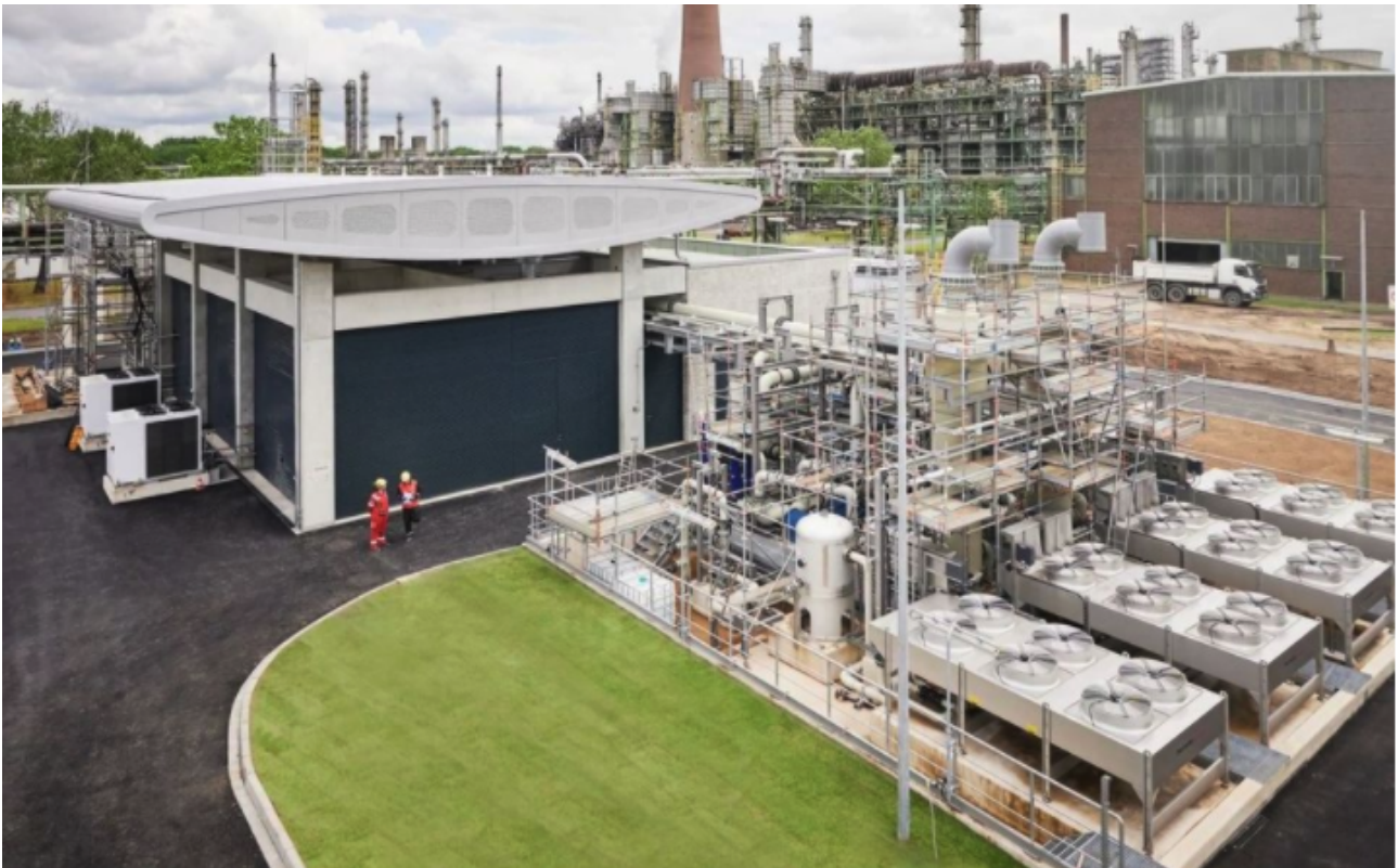
Bild 3: Kleiner 10MW-Elektrolyseur Quelle: Shell, D
