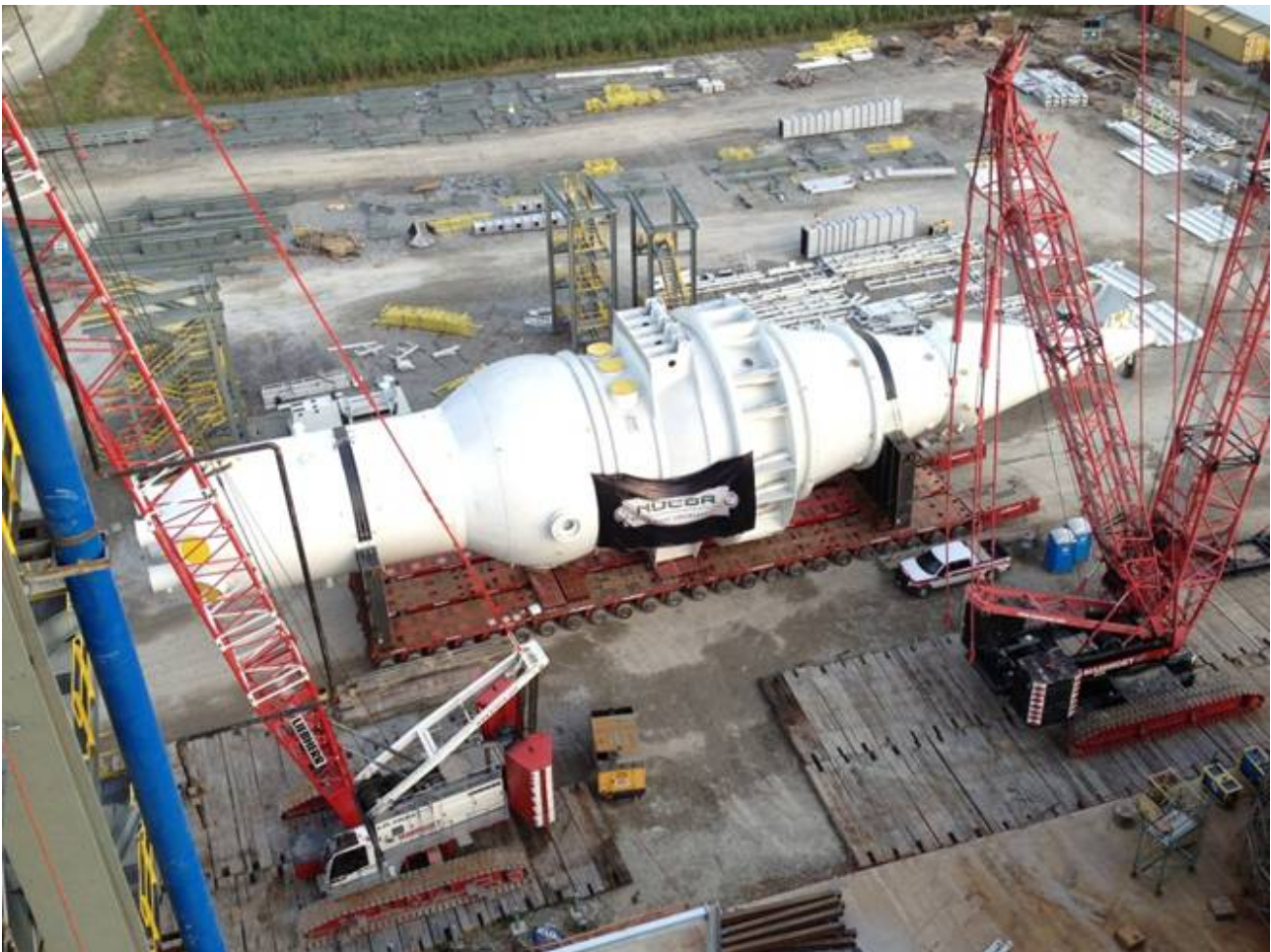
Bild 4: Weltgrößter Eisenschwamm-Reaktor Quelle: Nucor, USA
