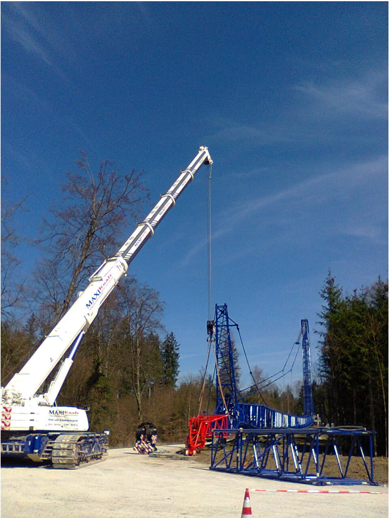
Der Mobilkran wird aus Einzelstücken zusammengesetzt
