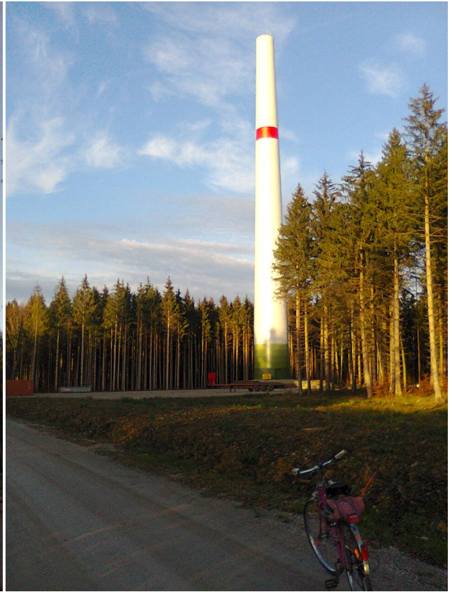
Der untere Teil ist aus Betonfertigteilen zusammengesetzt
