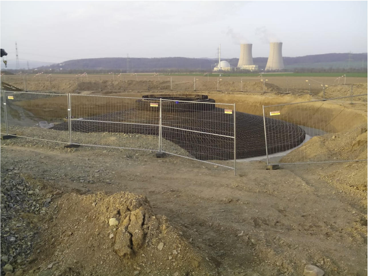
Fundament der 3.5 MW Vestas Anlage, Hintergrund KKW Grohnde, Bild Stephan Stallmann
