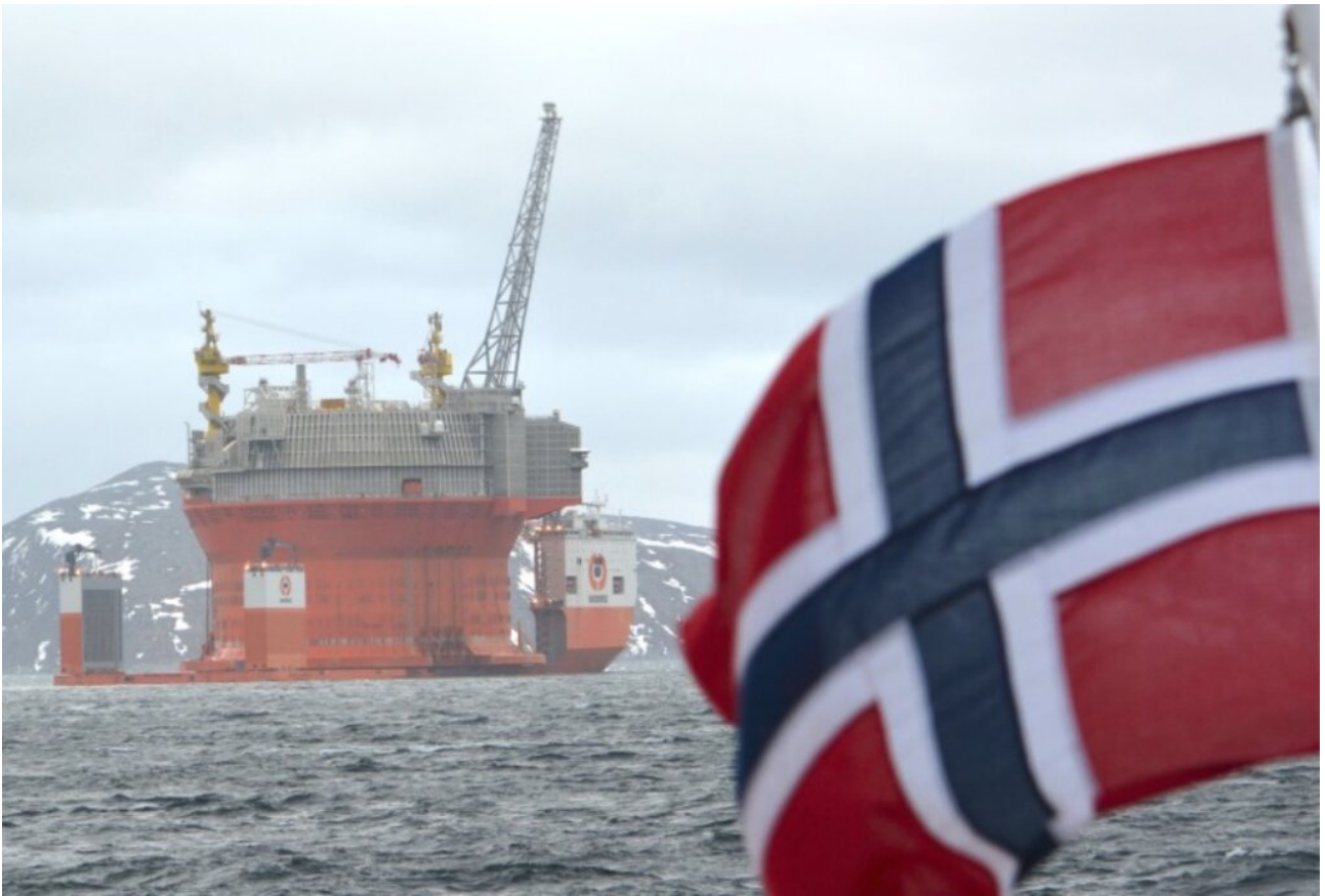
Abb.: Die norwegische Öl- und Gasindustrie läuft auf Hochtouren und füllt die Staatskasse. Screenshot
