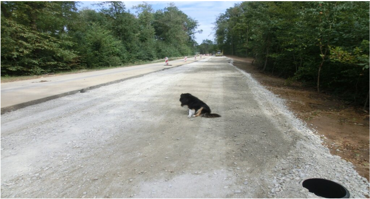
Abb. 8b: Vor 60 Jahren noch ein dichter Wald, wo sich die Bäume über dem Sträßchen mit ihren ausufernden Ästen begrüßen durften, entsteht eine breite Kreisstraße mit Geh- und Radweg. Rechts vorne ist der Einlaufschacht für die umfangreiche Entwässerung zu sehen. Das Entwässerungsrohr in 1m Tiefe legt selbstverständlich auch den angrenzenden Wald trocken. Foto Kowatsch
