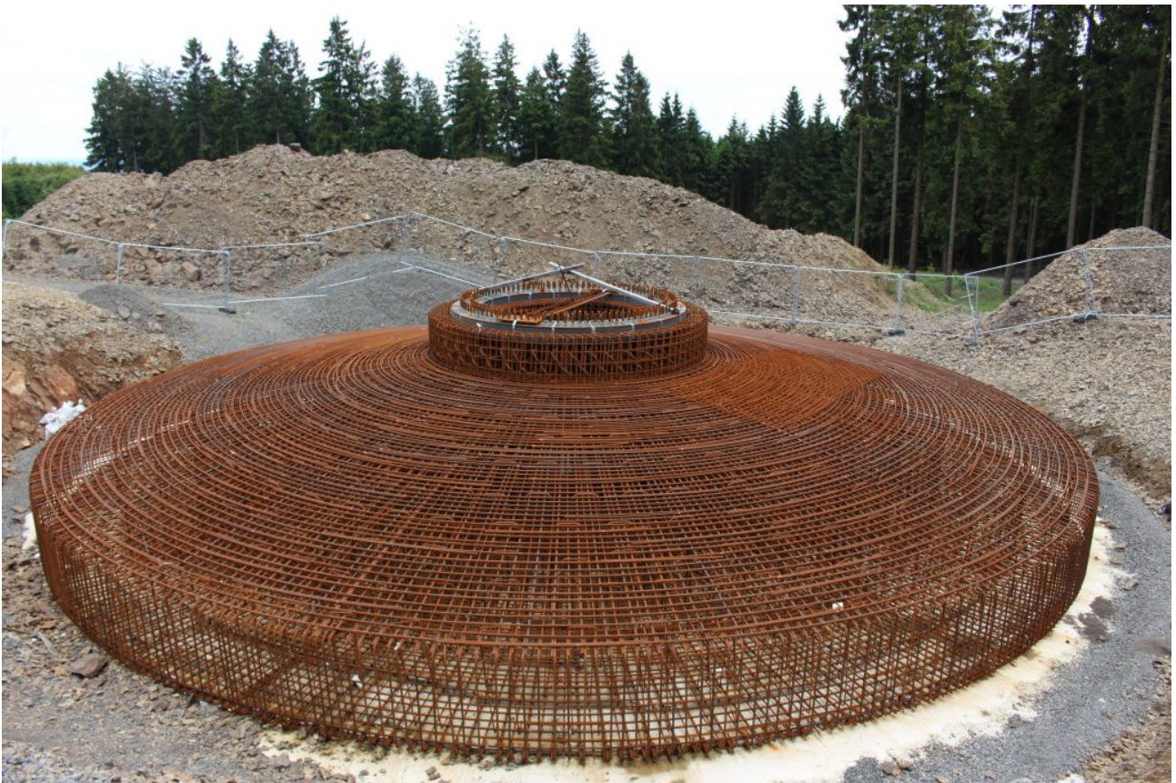
Abbildung 7d: Foto: Alexander Blecher, Das Gesamtfundament hat ein Gewicht von 4000 Tonnen.
