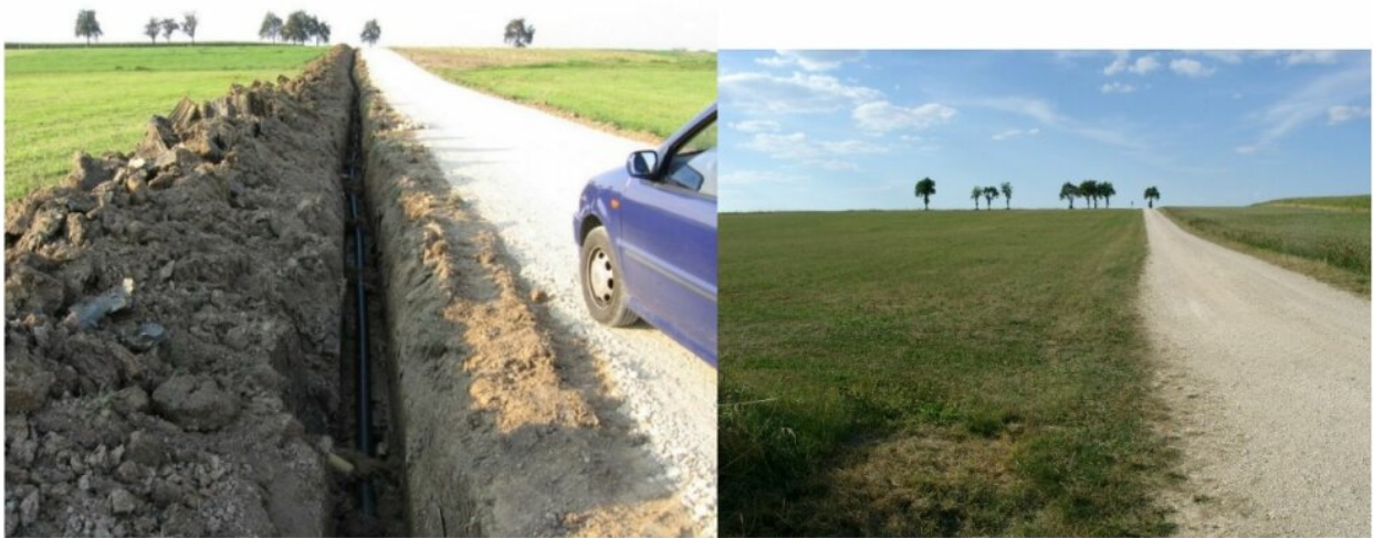
Abb. 9: Deutschlands Fluren sind großflächig mit Drainagen und perforierten Sickerschläuchen trockengelegt. Übrigens auch die Wälder. Zur schwarzen Drainageleitung entlang des Feldweges münden auf dem Bild von links alle 15 Meter gelbe Saugleitungen, welche die Wiese trockenlegen. Die erste gelbe Saugleitung ist erkennbar. In trockenen Sommern sieht die Wiese dann braungrüngelb aus mit spärlichem Grasbewuchs im August. (rechtes Bild). So erzeugt man Steppen in Deutschland. Fotos Worm/Kowatsch.
