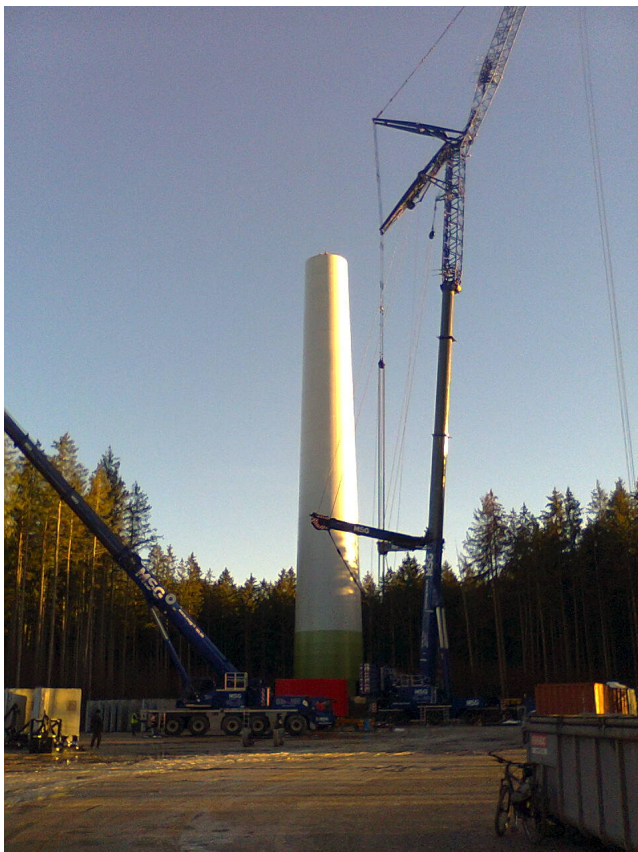
Der Fuß vom Windradl wird demnächst mit Beton vergossen
