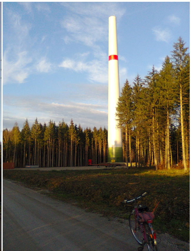
Der Fuß vom Windradl wird demnächst mit Beton vergossen
