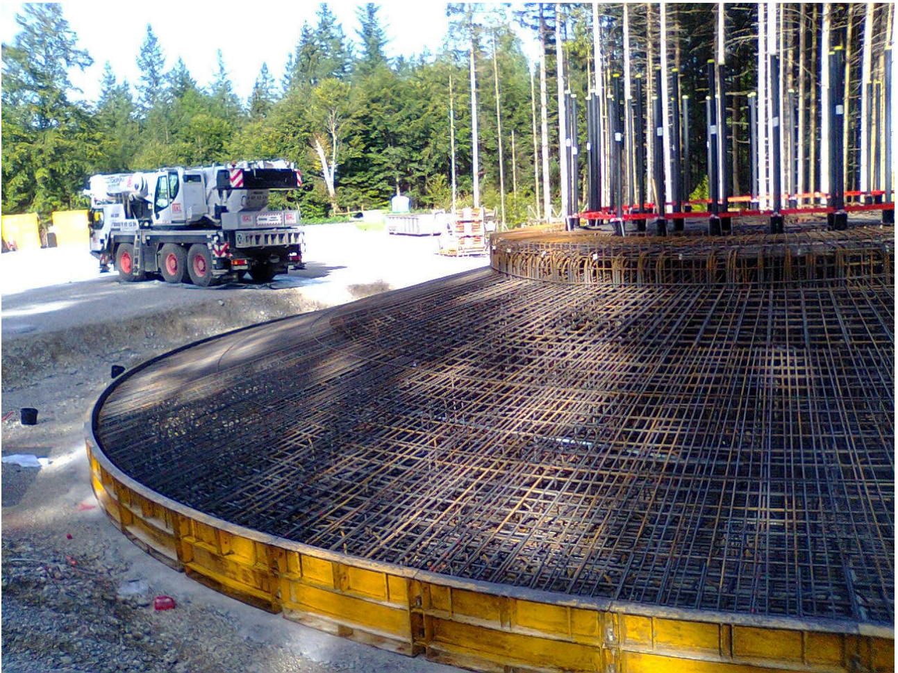
Der Fuß vom Windradl wird demnächst mit Beton vergossen
