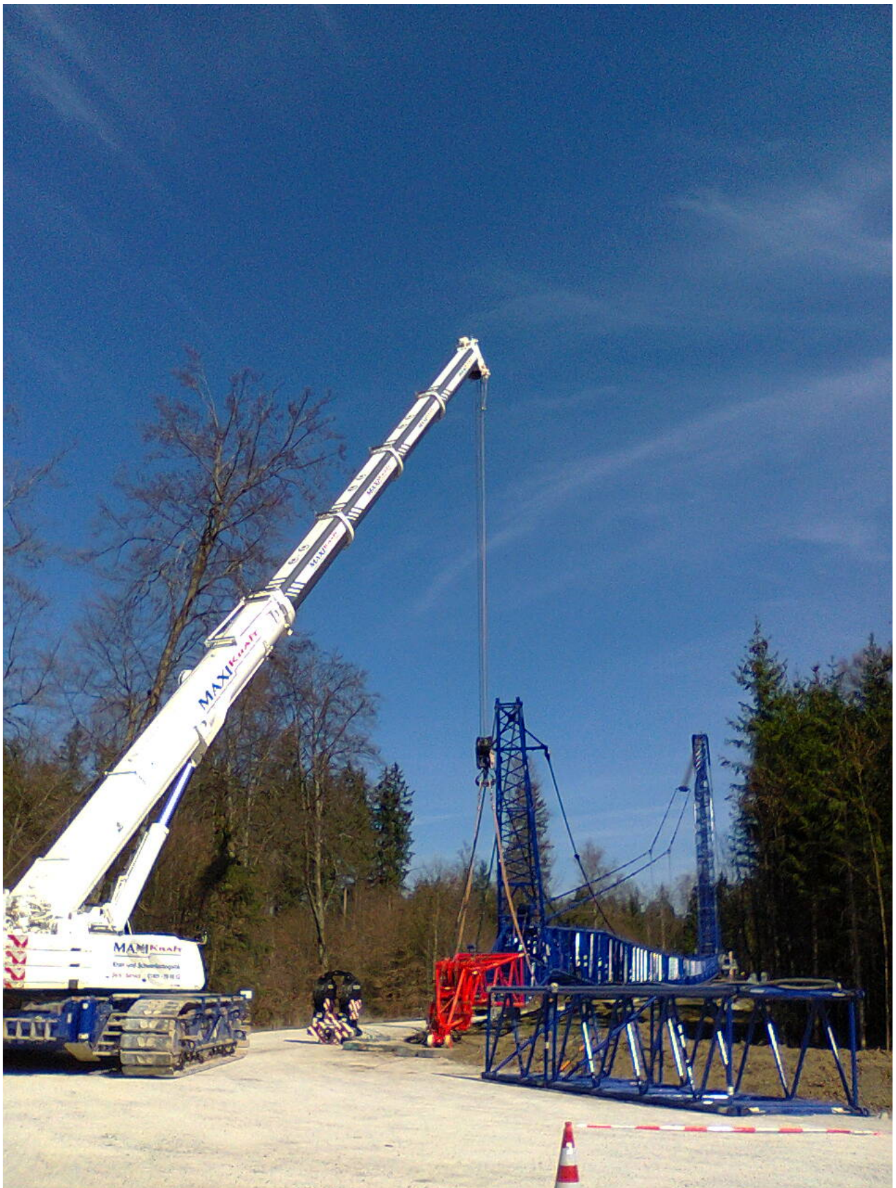
Der Mobilkran wird aus Einzelstücken zusammengesetzt
