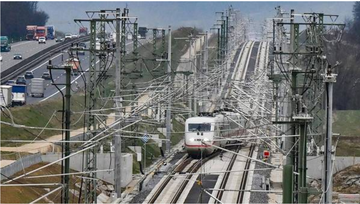
Bild: Schwäbische Zeitung. Ausbau von Stuttgart 21
