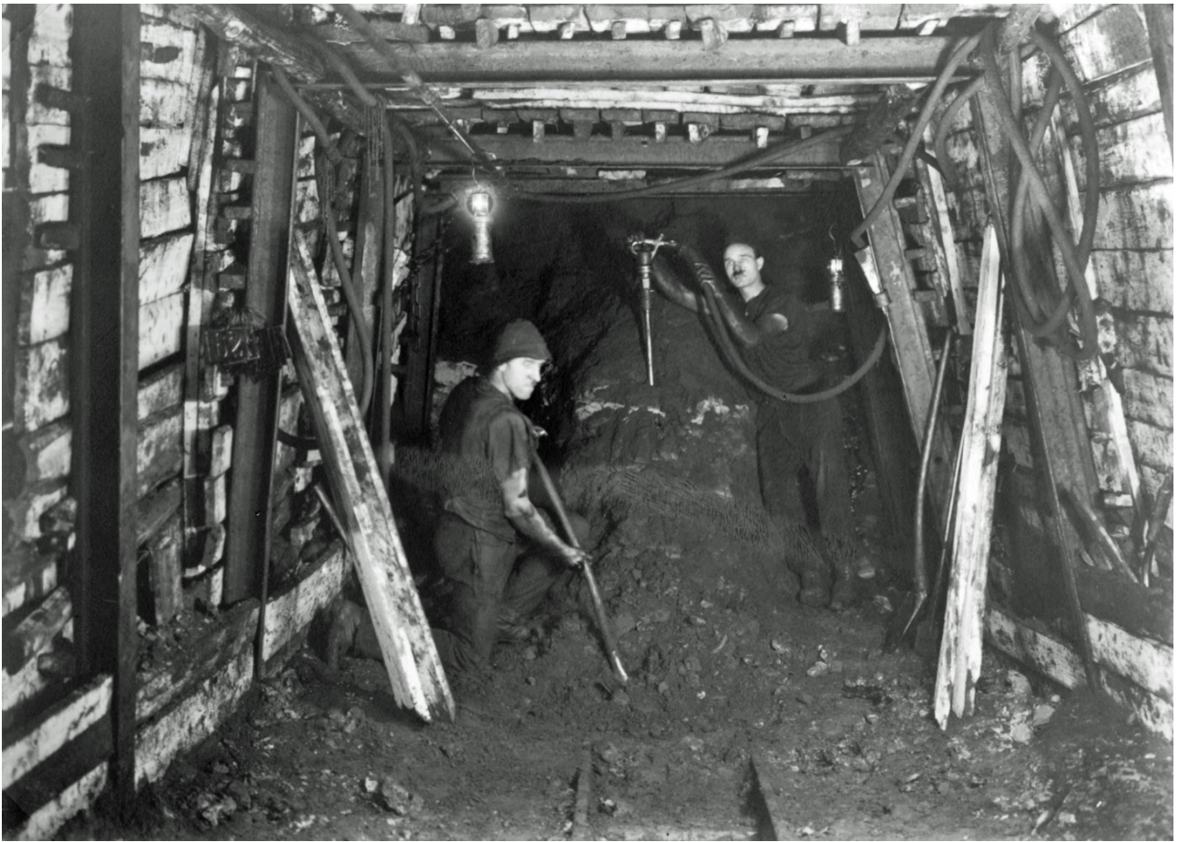
Abbildung 6 Bergmännischer Abbau von Ölsand (Archiv Deutsches Erdölmuseum)
