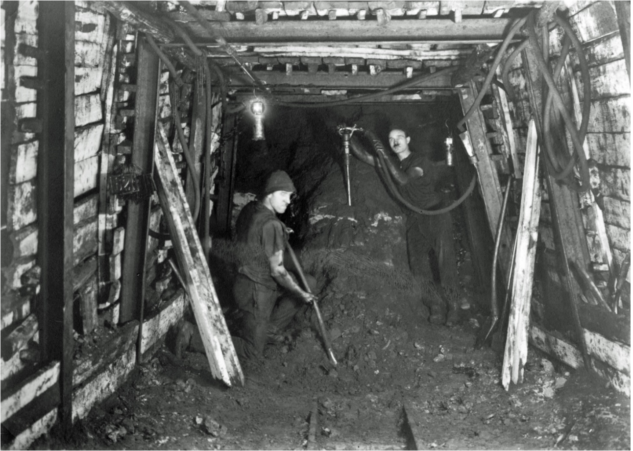
Abbildung 6 Bergmännischer Abbau von Ölsand (Archiv Deutsches Erdölmuseum)
