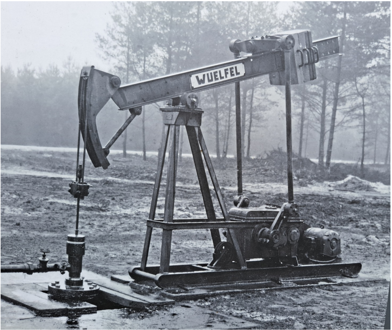
Abbildung 9 Erdölförderpumpe in den 50iger Jahren (Klaus Ridder)
