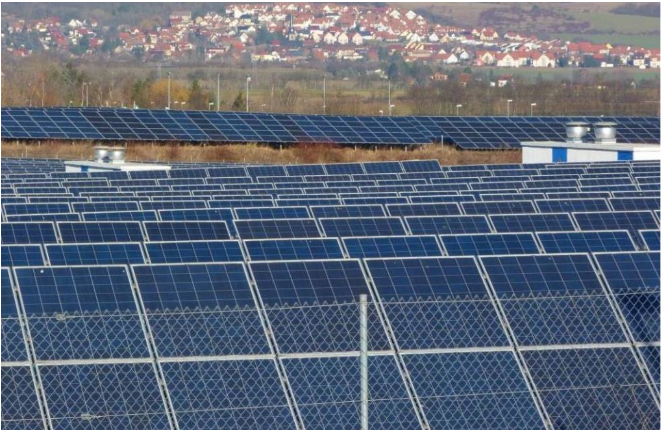
Bild 5: Freiflächen-PV-Anlage in Mitteldeutschland, wenn die Sonne scheint, entsteht nicht nur Strom, die dunklen Flächen wirken wie ein heißer Backofen in der freien Landschaft. Foto: Kämpfe
