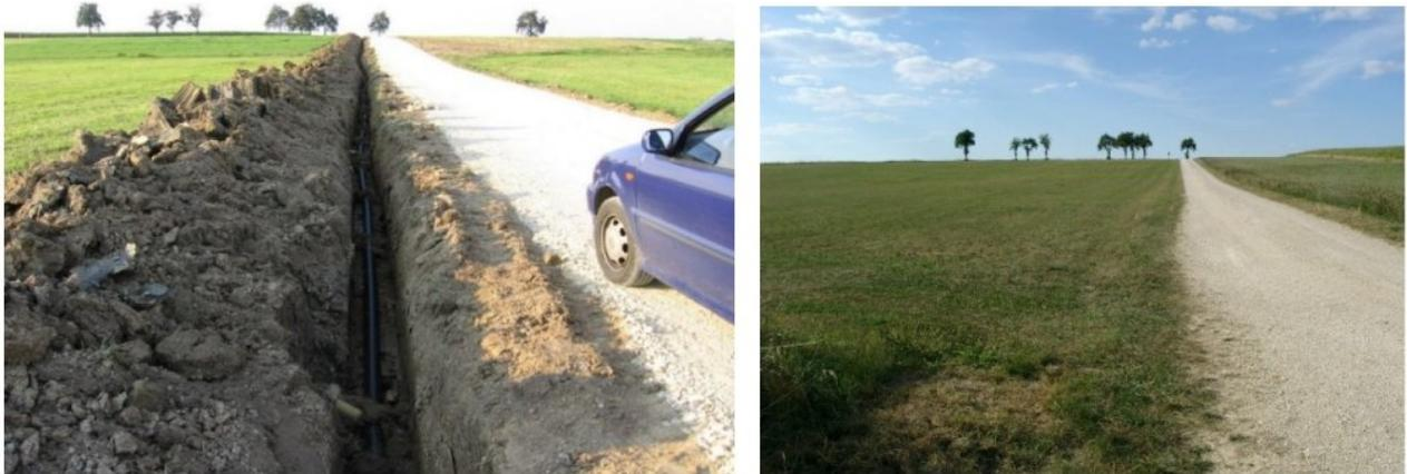
Bild 4: Deutschlands Fluren sind großflächig mit Drainagen und Sickerungsschläuchen trockengelegt. Übrigens auch die Wälder. Zur schwarzen Drainageleitung entlang des Feldweges münden von links alle 15 Meter gelbe Saugleitungen ein, welche die Wiese trockenlegen, Die erste (unten im Graben) ist erkennbar. Im Sommer sieht die Wiese dann braungrünelb aus mit spärlichem Grasbewuchs im August. (rechtes Bild). So erzeugt man Steppen in Deutschland. Fotos Worm/Kowatsch
