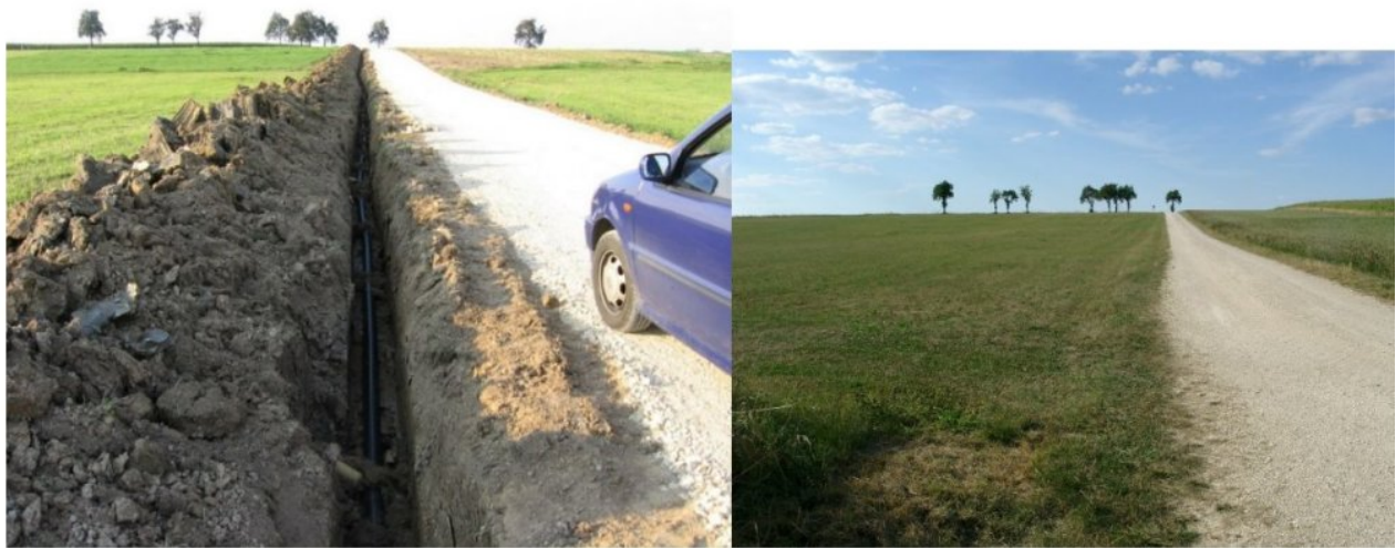
Abb. 8: Deutschlands Fluren sind großflächig mit Drainagen und Sickerungsschläuchen trockengelegt. Übrigens auch die Wälder. Zur schwarzen Drainleitung entlang des Feldweges münden von links alle 15 Meter gelbe Saugleitungen, welche die Wiese trockenlegen, Die erste ist erkennbar. Im Sommer sieht die Wiese dann braungrüngelb aus mit spärlichem Grasbewuchs im August. (rechtes Bild). So erzeugt man Steppen in Deutschland. Fotos Worm/Kowatsch.
