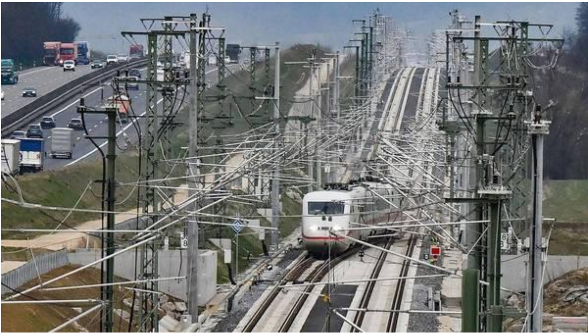
Bild: Schwäbische Zeitung. Ausbau von Stuttgart 21
