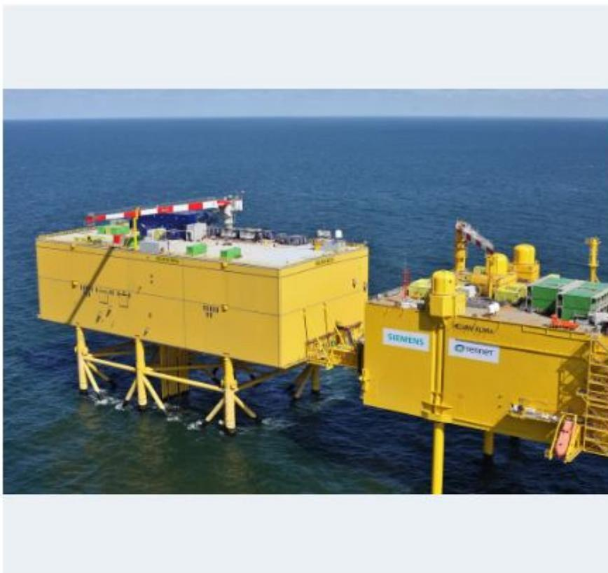
Mit der Offshore-Plattform HelWin2 können bis zu 690 Megawatt (MW) an Ökostrom übertragen werden, was zur Versorgung von fast 900.000 deutschen Haushalten ausreicht. Die Offshore-Plattform der HelWin2-Verbindung liegt etwa 85 Kilometer von der Küste – nordwestlich der namensgebenden Insel Helgoland.
