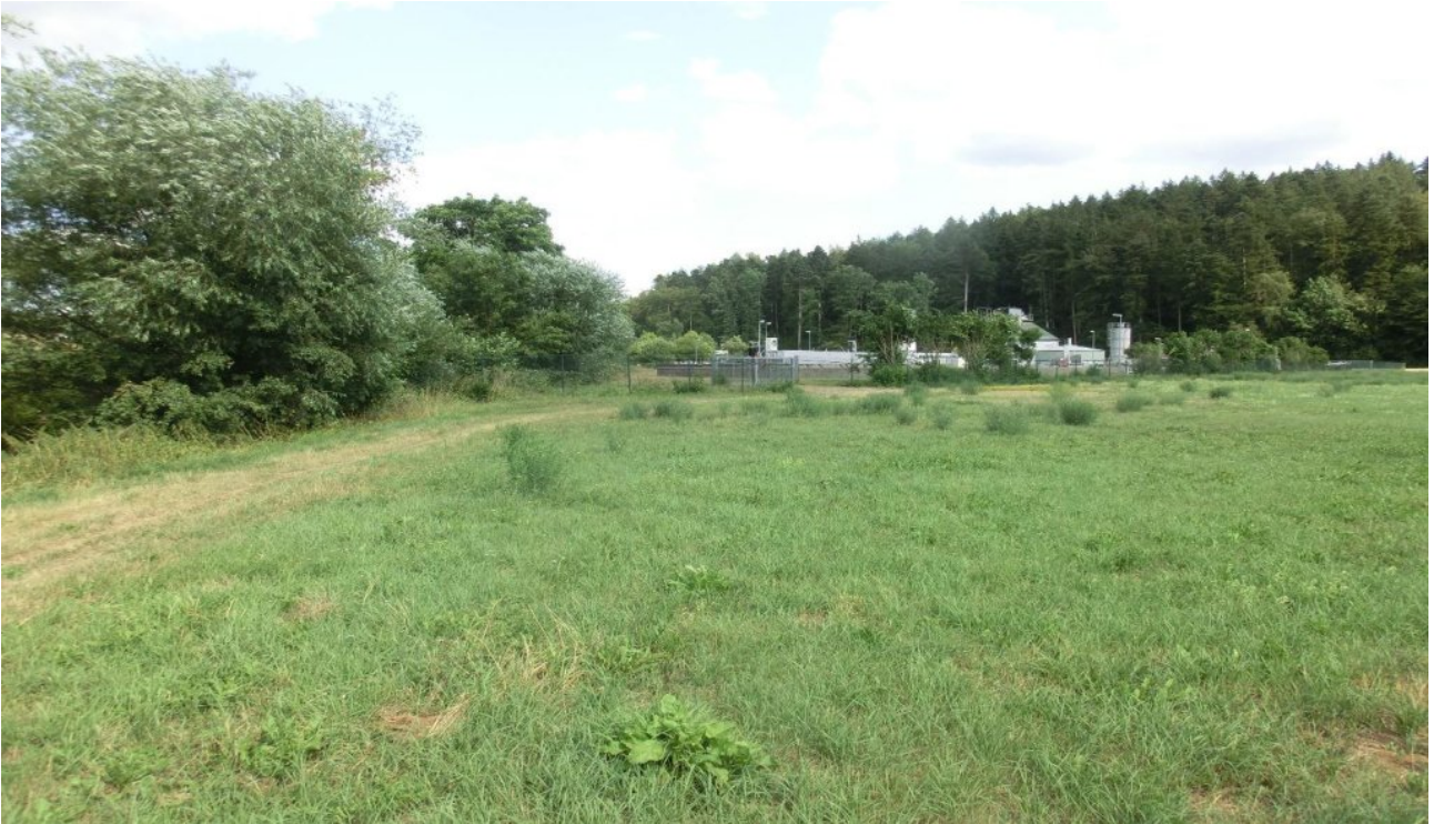
Abb.11 Kläranlagen: Wiederverwendung des gereinigten Abwassers, durch Auffangbecken, bzw. Weiher in der Wiese. Foto Kowatsch.
