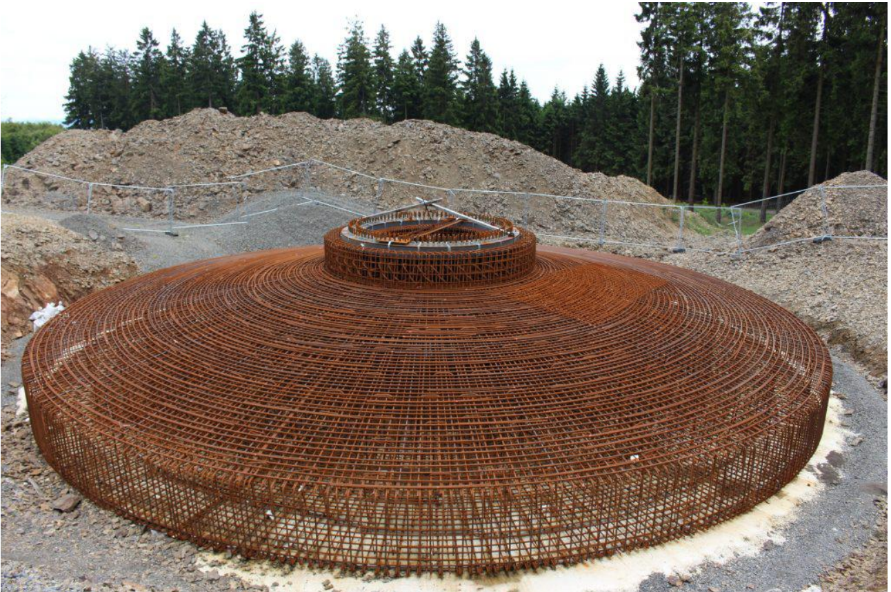
Abbildung 7b: Foto: Alexander Blecher, Das Gesamtfundament hat ein Gewicht von 4000 Tonnen.
