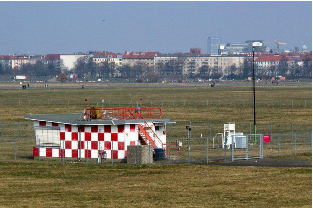
Abb.21, Quelle wie Abb.13. Text: „Ansicht der Station Berlin-Tempelhof,“
