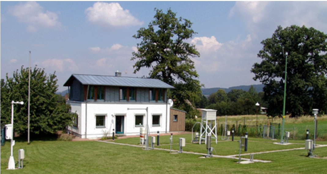
Abb. 18, Quelle: DWD, zeigt die DWD Temperaturmessstation Weiden inmitten scheinbar unberührter Natur. Werfen wir daher einen Blick auf google-earth.
