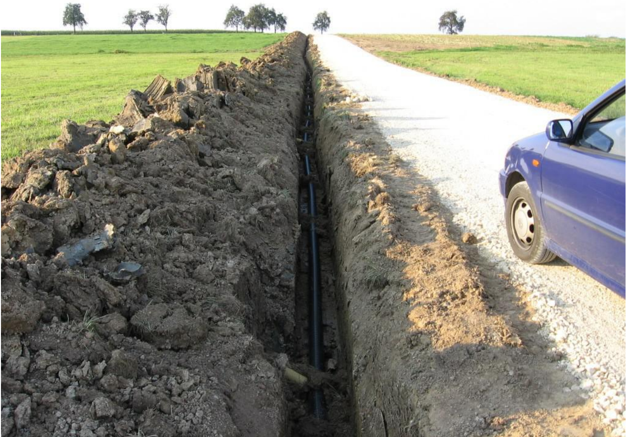
Abbildung 3: Die Feldwege werden zusätzlich am Straßenrand mit Drainagen versehen, von den landwirtschaftlichen Flächen münden etwa alle 10 bis 15m gelbe Sickerschläuche in 1m Tiefe –siehe ganz vorne links – in den schwarzen Entwässerrungshauptleiter.
