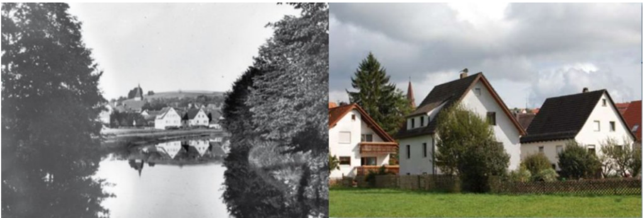
Abb. 7: Der Flusslauf wurde eingeeengt und Auenwiese allmählich zugebaut. Die Häuser in verdichteter Bebauung reichen heute bis auf 10 m an den eingeeengten Flusslauf, teilweise stehen sie im früheren Kocherbett. Hochwasser vorprogrammiert?
