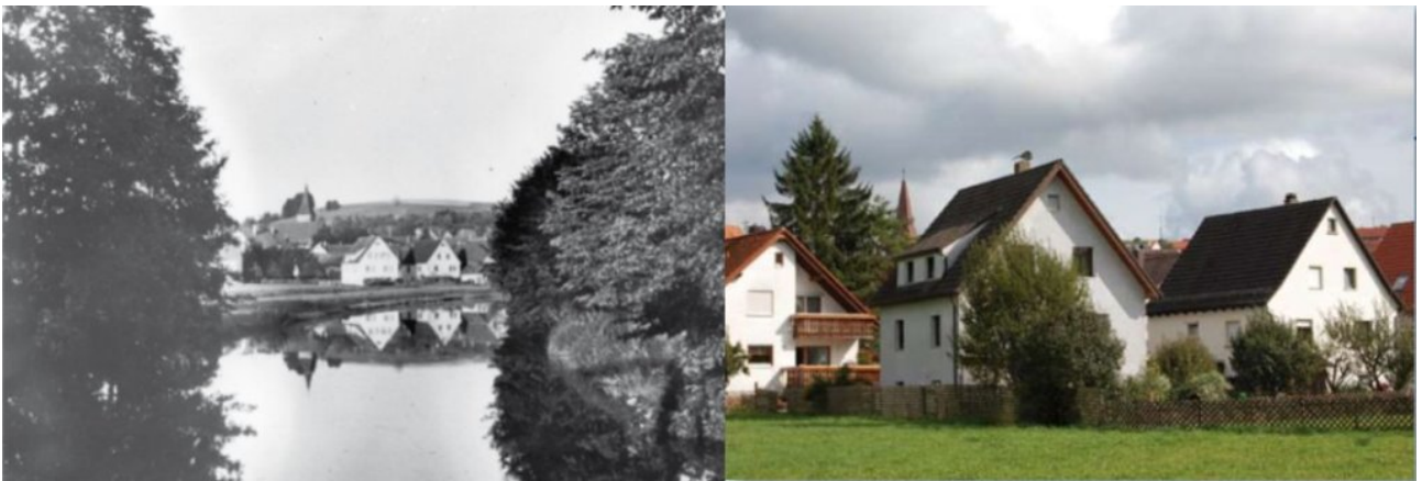
Abb. 7: Der Flusslauf wurde eingengt und Auenwiese allmählich zugebaut. Die Häuser in verdichteter Bebauung reichen heute bis auf 10 m an den eingengten Flusslauf, teilweise stehen sie im früheren Kocherbett. Hochwasser vorprogrammiert?
