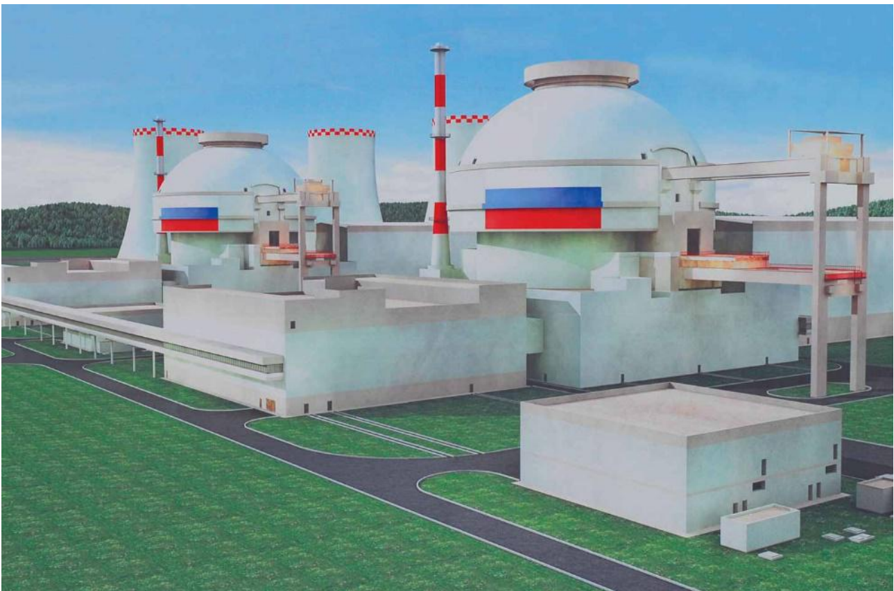
Bild 3. Darstellung eines älteren Planungskonzepts des Novovoronezh Kernkraftwerks II mit zwei VVER-1200/392M bzw. AES-2006-Reaktoren (Grafik: Rosenergoatom, Creative Commons Attribution 3.0 Unported license )
