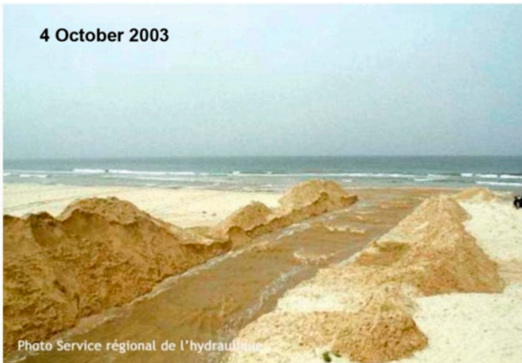
Bild 11 Bei der Flut 2003 erstellter Entlastungskanal (New river mouth) am Tag der Errichtung [11]
