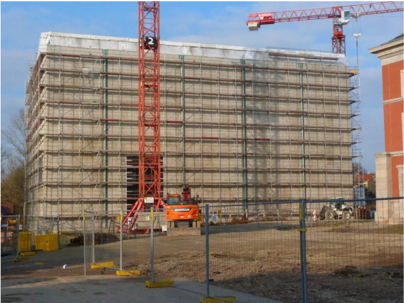
Abbildung 10: Die Errichtung des neuen Bauhaus-Museums am Nordwestrand der Weimarer Altstadt zerstörte zwei Grünflächen und beeinträchtigte den Nordrand des Weimarhallenparkes; zahlreiche Bäume wurden gefällt, und der neue, sehr klobige Baukörper verringert die Belüftung der angrenzenden Stadtviertel. Zustand im Rohbau, Januar 2018. Foto: Stefan Kämpfe
