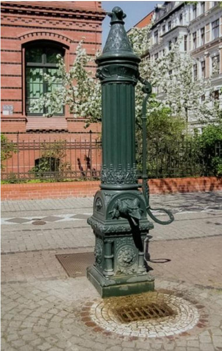
Bild 11: Brunnen mit Schwengelpumpe, wie er u. a. in Magdeburg und Berlin als Notbrunnen deklariert ist. Mit einer Förderleistung von ca. 1.200 Liter pro Stunde könnte er innerhalb von 12 Stunden den Minimalbedarf von 900 Menschen decken. Sein Versorgungsgebiet dürfte wohl die zehnfache Einwohnerzahl enthalten. Quelle: /31/
