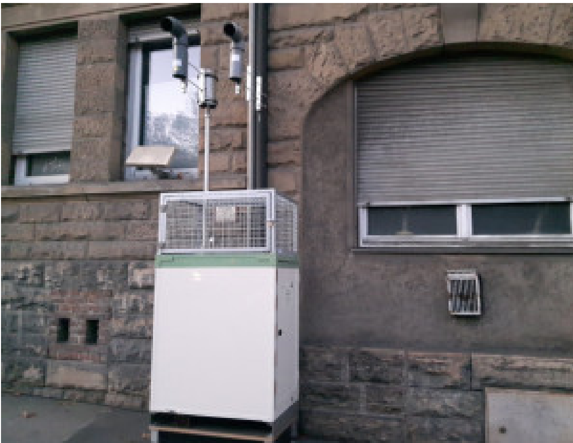
Messstation mit Gas-Entlüftung, Bild Autor
