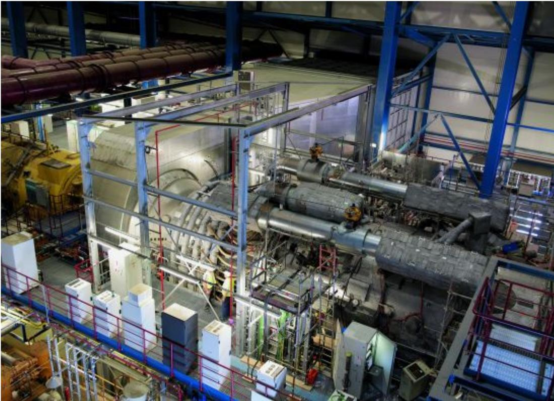
Die Turbine SGT5-8000H in Irsching wird in Verbindung mit einer Dampfturbine einen Rekord beim Wirkungsgrad aufstellen: mehr als 60 Prozent. Nirgendwo auf der Welt wurde dies bisher erreicht.
