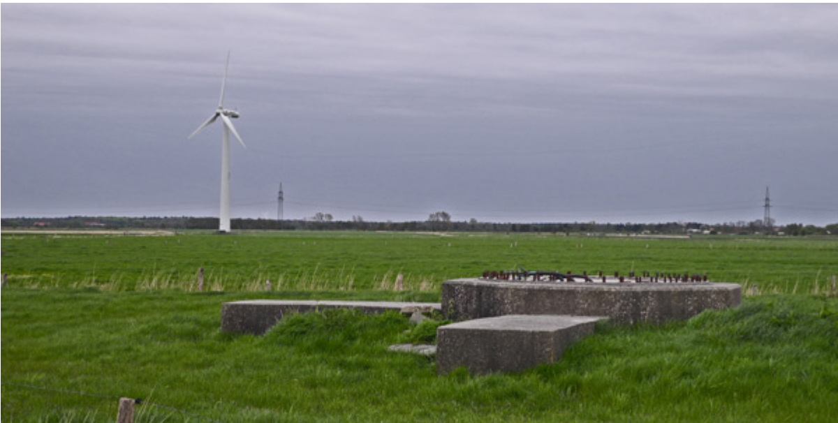
Fundament der nach einem Gerichtsurteil versetzten „Zeiger-Mühle“ in Oldendorf/Bensersiel, LK Wittmund. Im Hintergrund die versetzte Anlage, Foto (C): Manfred Knake
