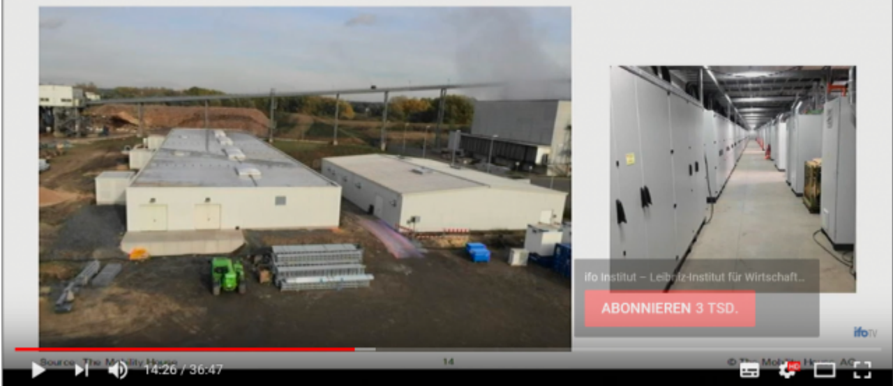
Bild 3 Projektbild Daimler mit 1000 E-Smart-Akkus. Ansicht des fertigen Speicher-Gebäudes. Quelle: Screenshot aus dem Vortragsvideo
