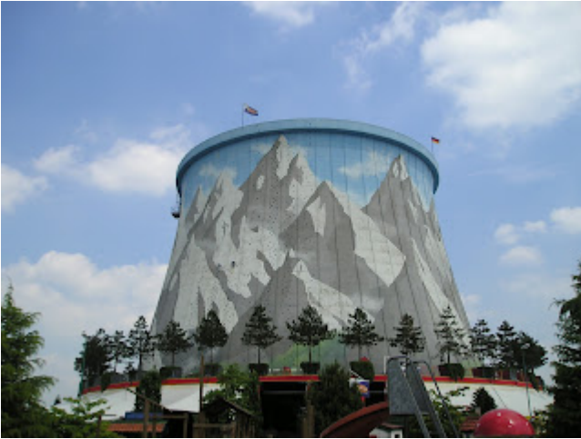
Der bemalte Kühlturm des SNR 300 in Kalkar als Klettergerüst Übernommen vom Rentnerblog hier
