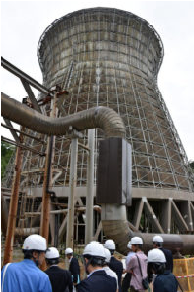
Kühlturm des Matsukawa geothermischen Kraftwerks, 46 Meter hoch.
