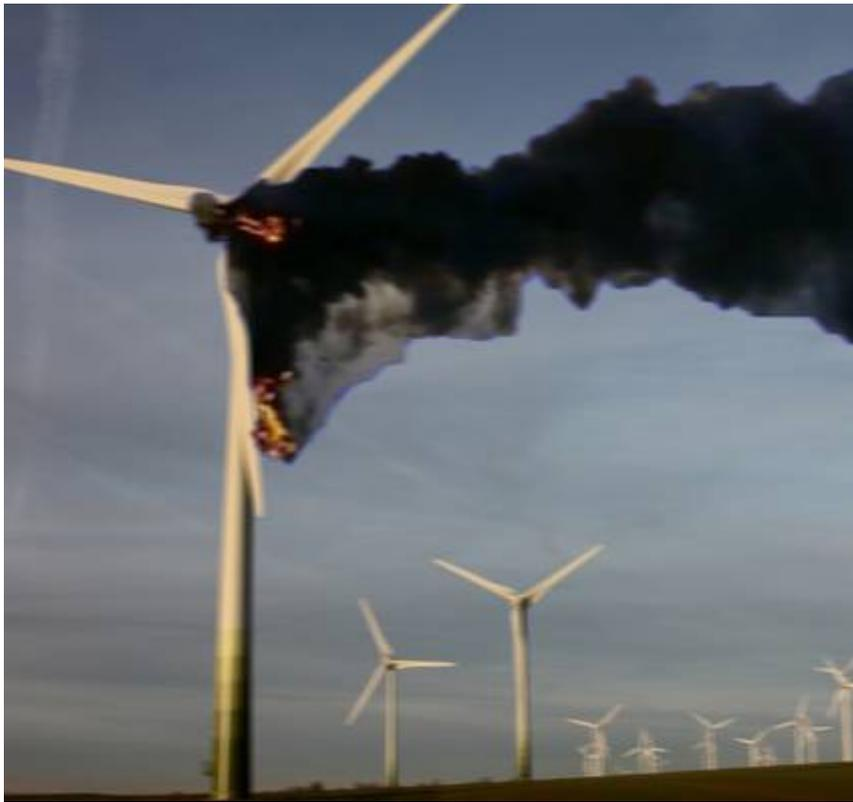
Brände in Windenergieanlagen sind in der Regel nicht löschar
