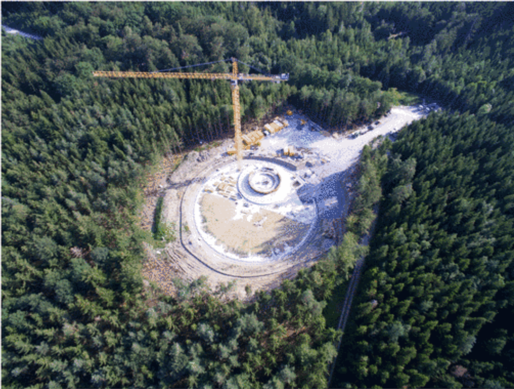
Blick am 30. Juli 2016 von oben auf die Baustelle der WEA 3
