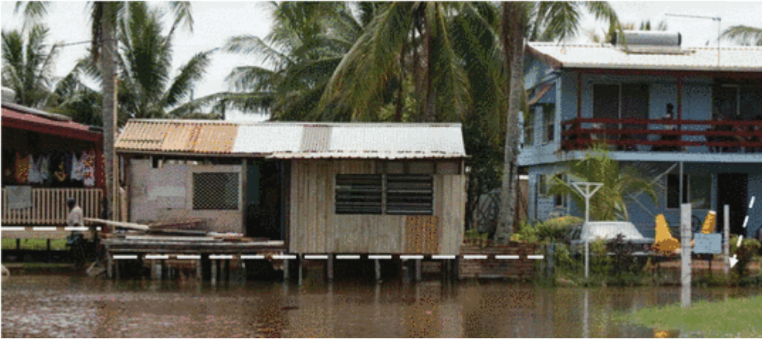
Bild 15 [17] Originaltext: Inundation (Überschemmung) in the Saibai Island. (Source TSRA). Die gestrichelten, weissen Linien sind vom Autor zugefügt
