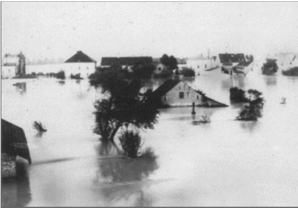
Blick vom Inndamm auf das Hochwasser 1899. Am linken Bildrand ist das Portal der Innbrücke zu erkennen (entnommen aus dem Buch Unser Simbach von Rudolf Vierlinger)
