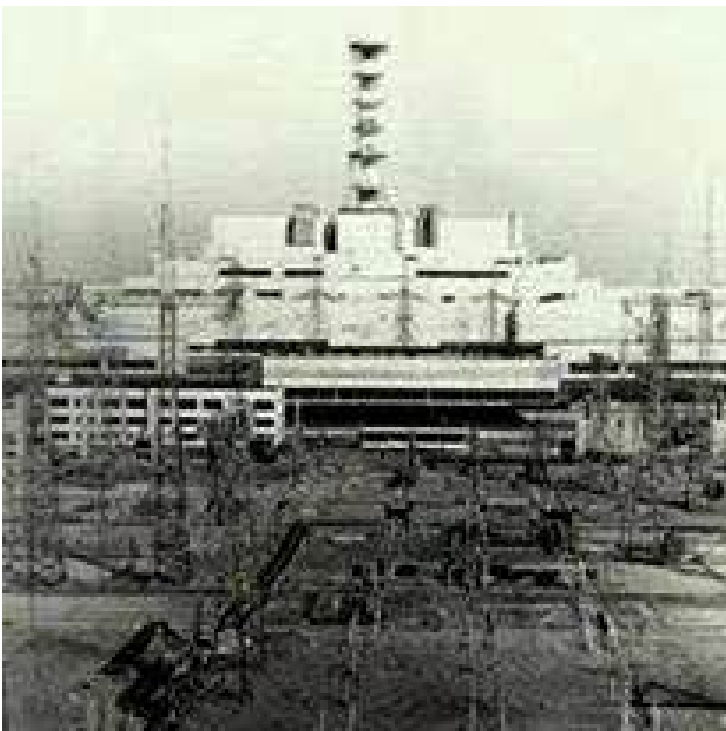
Kernkraftwerk Tschernobyl, Blöcke 3 und 4 (links), von Süden aus gesehen. Fotografiert 10 Tage vor dem Unfall von Elektromonteur Ivan Zholud.
