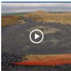
Fundamentarbeiten für Riesen-WEA im Sauerland
