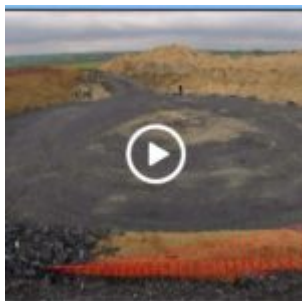
Fundamentarbeiten für Riesen-WEA im Sauerland
