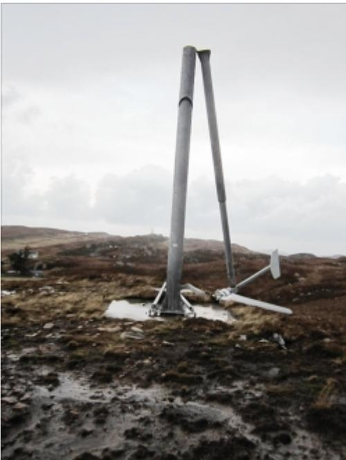
Bild: Der Turbinenmast brach in der Mitte durch. In der Folge stürzten das Gehäuse und die Rotorblätter zu Boden.
