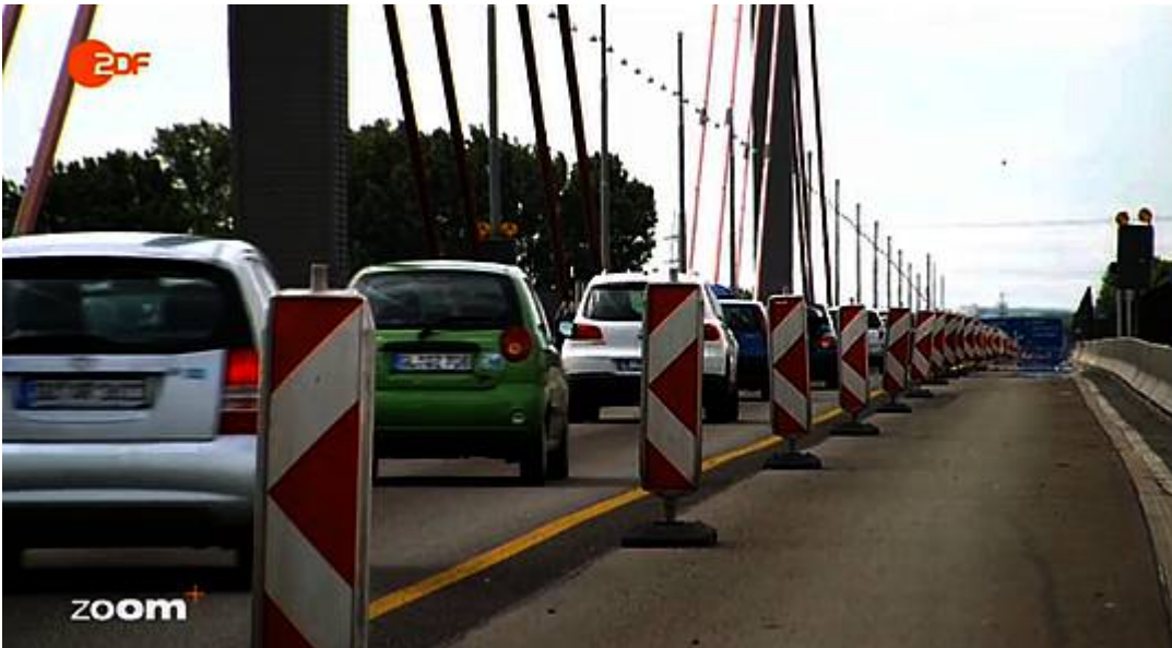
Abb. 3 Eine von zahlreichen aber immer noch viel zuwenig Baustellen auf Deutschlands Brücken. Bild aus ZDF Zoom "Kaputt gespart" Sehenswerte Details hier
