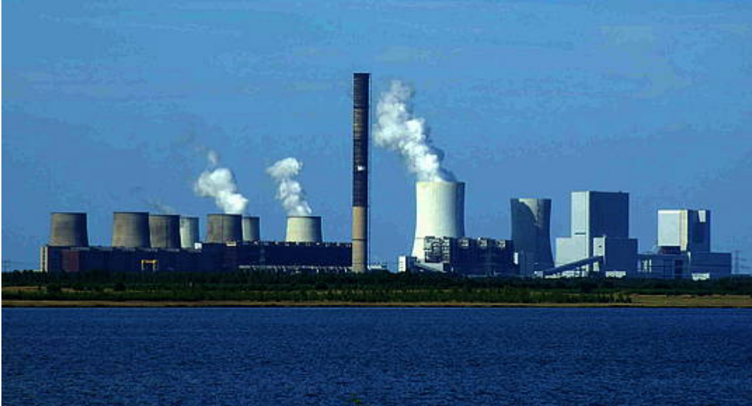
Bild 4. Großkraftwerke wie das 2575-MW-Braunkohlekraftwerk Boxberg kann man nicht einfach an- und abschalten wie ein Auto (Foto: Kohlekraftwerke.de)
